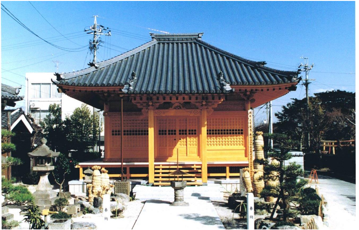
法海寺本堂再建<平成4(1992)年11月>
