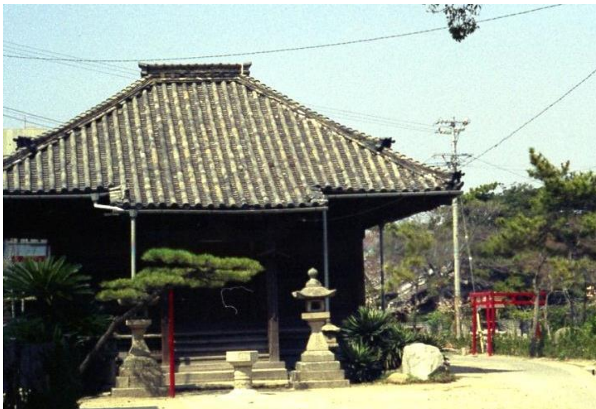
法海寺本堂<昭和 50 (1975) 年>
